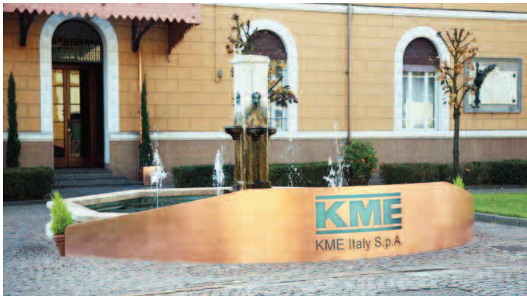
L'ingresso dello stabilimento KME di Fornaci di Barga
